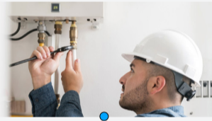
Instalação do sistema de aquecimento
